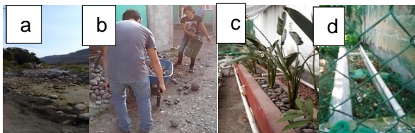
Figura 2. a y b) Colecta de piedras en el río Pinoltepec, Pastorias c) Celdas empacadas con diferente sustrato (piedra de río y piedra volcánica) y vegetación d) celdas control con diferente sustrato (piedra de río y piedra volcánica). Fuente: Elaboración propia
