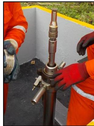
**Figura 10.** Colocación de porta-cupón con testigo corrosimétrico circular en "tapón sólido" instalado en equipo "retriver".
