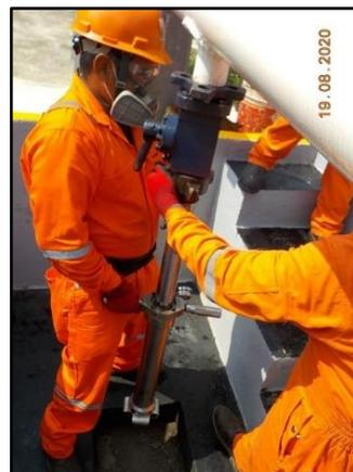
**Figura 11.** Vista de la inserción/retiro de cupón corrosimétrico.
