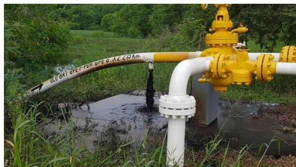
**Figura 1.** Acto Vandálico debido al retiro de Tapón Sólido del Niple Cosasco® (área contaminada).
