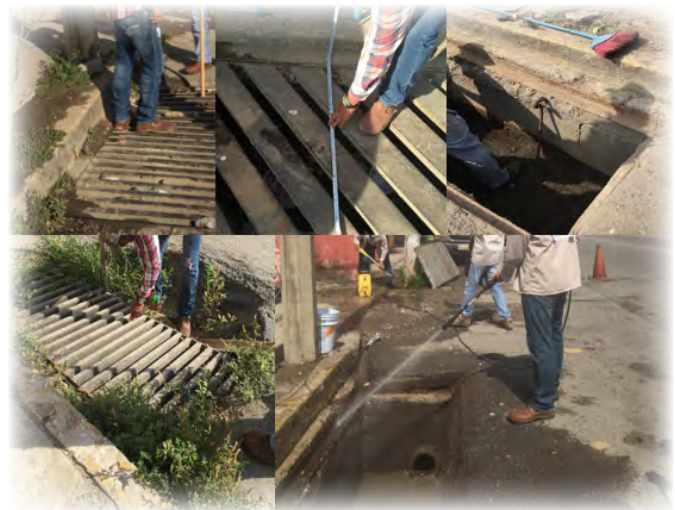
Fotografía 1. Inspección de los colectores ubicados en la zona de estudio.
