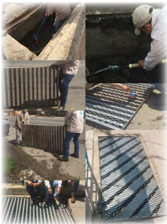
Fotografía 2. Mantenimiento de dos colectores y rediseño a las rejillas.
