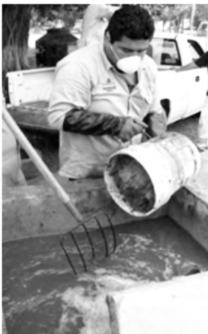
Alimentación del biodigestor tipo cúpula (67 m 3 )
