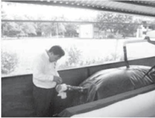
**Figura 1.** Instalación del biodigestor con su respectivo reservorio en la DACBIol
